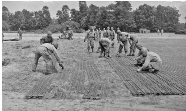
**P S P (Pierced Steel Plank) ou Placage d'acier perforé.** Fabrication américaine, une section de PSP en acier était d'environ 3 mètres de longueur et 40 cm de large. Sur le côté de chaque PSP, il y a des crochets et des trous pour les relier ensemble.
